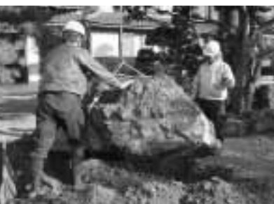
石があたかも初めからそこに存在したように、自然に見えるように据え付けるのが鉄則。事前に何パターンも頭の中に思い描いた上で、適した石を一番いい位置に据え付ける
