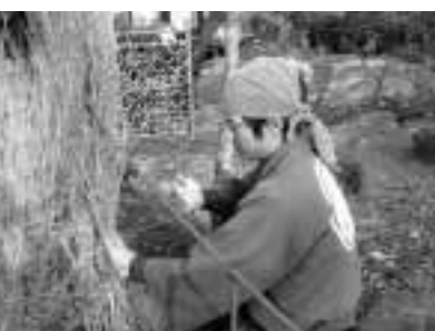
竹穂(竹の幹以外の枝)を適量に束にして骨組みに取り付けていく。軽やかに温かな雰囲気を出し出す。節を揃えたり、枝の切り方に個性が出る
