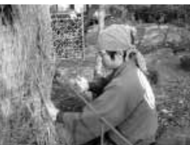
竹穂(竹の幹以外の枝)を適量に束にして骨組みに取り付けていく。軽やかで温かな雰囲気を出す。節を揃えたり、枝の切り方に個性が出る
