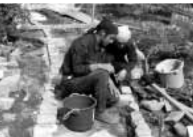
石の組み合わせを考えながら、石畳の道を作っていく。庭造りの中でも地道な作業の一つ
