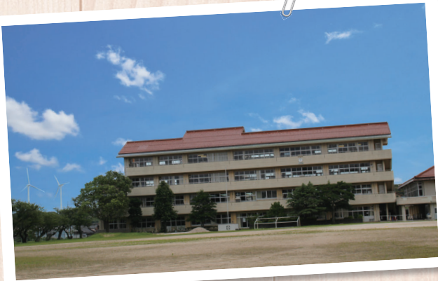
多伎中学校の校舎
